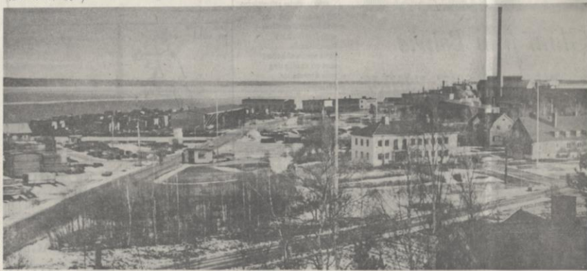
Det mesta kring Rundviks samhälle domineras av masonitefabriken.
